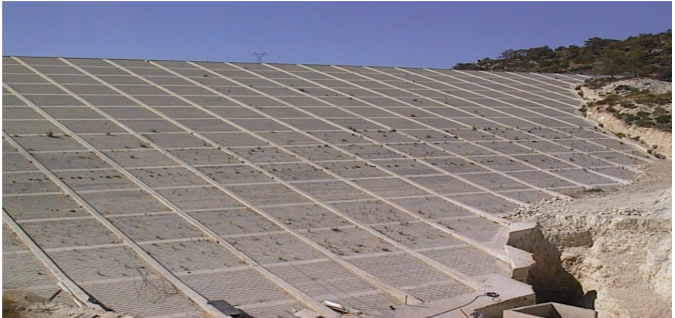
Above : Rockfill Dam
