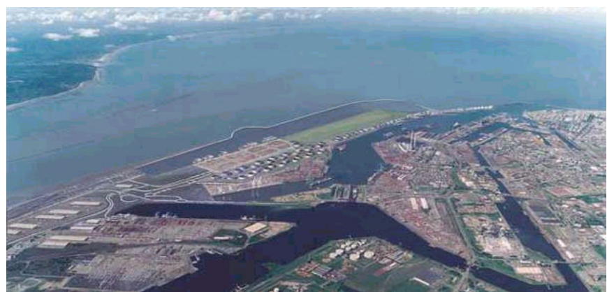
Le Havre : Port 2000 Project
